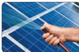
Enxaguar com água, ou remover o produto com papel de cozinha. Para superfícies particularmente sujas repetir a operação.
