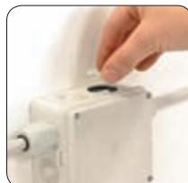
Fechar o furo utilizado para o vazamento com a tampa fornecida; instalação concluída. Aguardar pela reticulação completa do produto antes de abrir a caixa de derivação.
