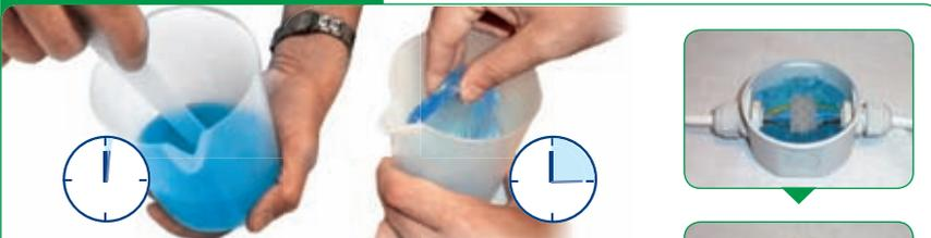
Despejar os componentes no medidor, misturar e aguardar o término do processo de reticulação (aproximadamente 15 minutos). Retirar o isolante e colocá-lo em pequenos pedaços ao redor da conexão de forma a cobri-la completamente. Pode ser naturalmente utilizado o isolante proveniente de trabalhos anteriores e conservado.
