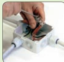
Desfilando los cables y realizando la conexión.
