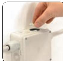
Cerra el orificio empleado para el colado con el tapón entregado; Instalación finalizada. Esperar la reticulación completa del producto antes de realizar la apertura de la caja.
