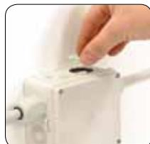
Chiudere il foro impiegato per la colata con il tappo in dotazione; installazione terminata. Attendere la reticolazione completa del prodotto prima di un'eventuale apertura della cassetta.
